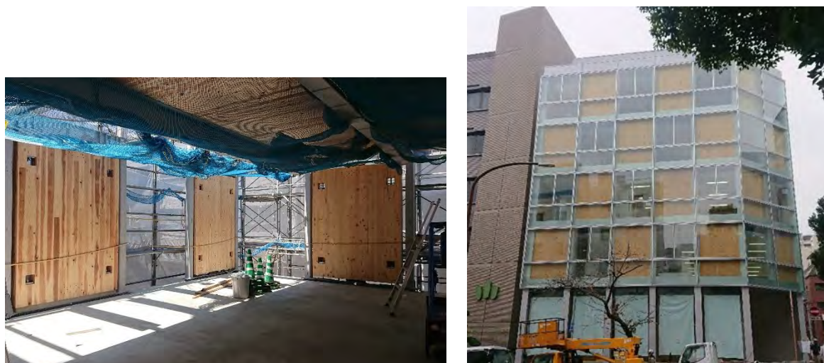
図9 鉄骨造と CLT 壁を併用した構造 (左：内部 右：完成後)
