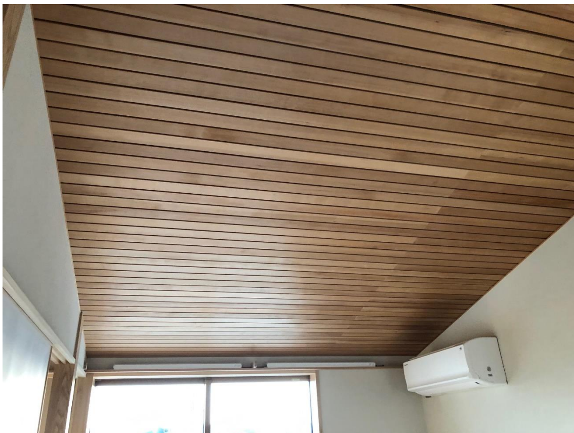
【2階天井部位は目透かし天井張りの工夫が施されています】
