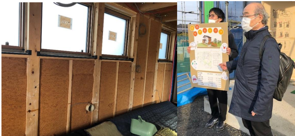
【シュタイコ木繊維断熱材を充填した壁面（左）、解説する半田先生、隣は館林林業の原専務】
