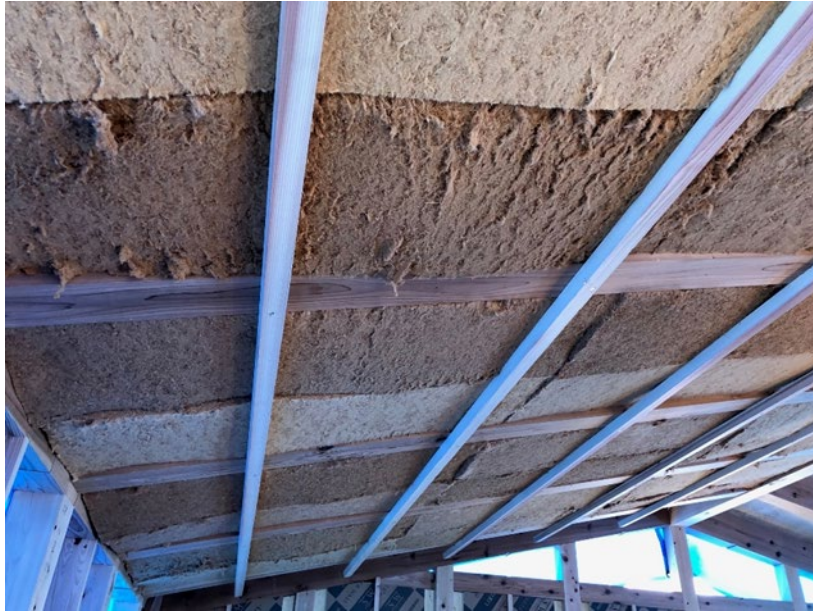
【屋根に二重施工されたシュタイコ木繊維断熱材】
