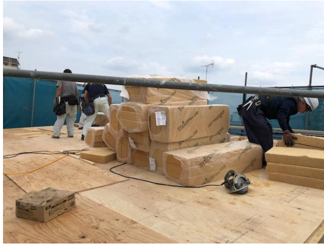
【屋根断熱施工の様子】
