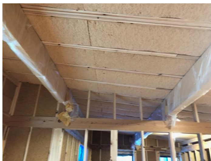
【フレックス 038 を付加断熱とした小屋裏】
